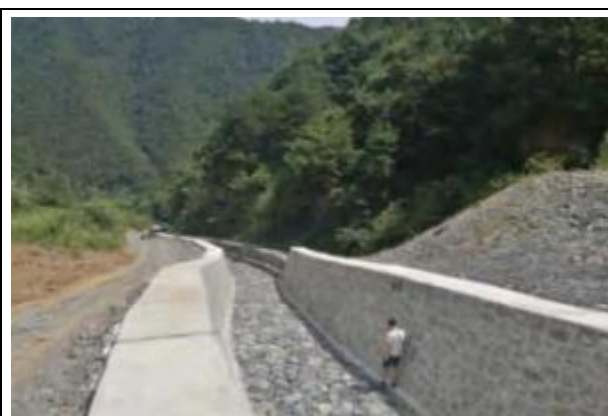
照片 2.6-1 拦渣墙及排洪渠（镜向 20°）
